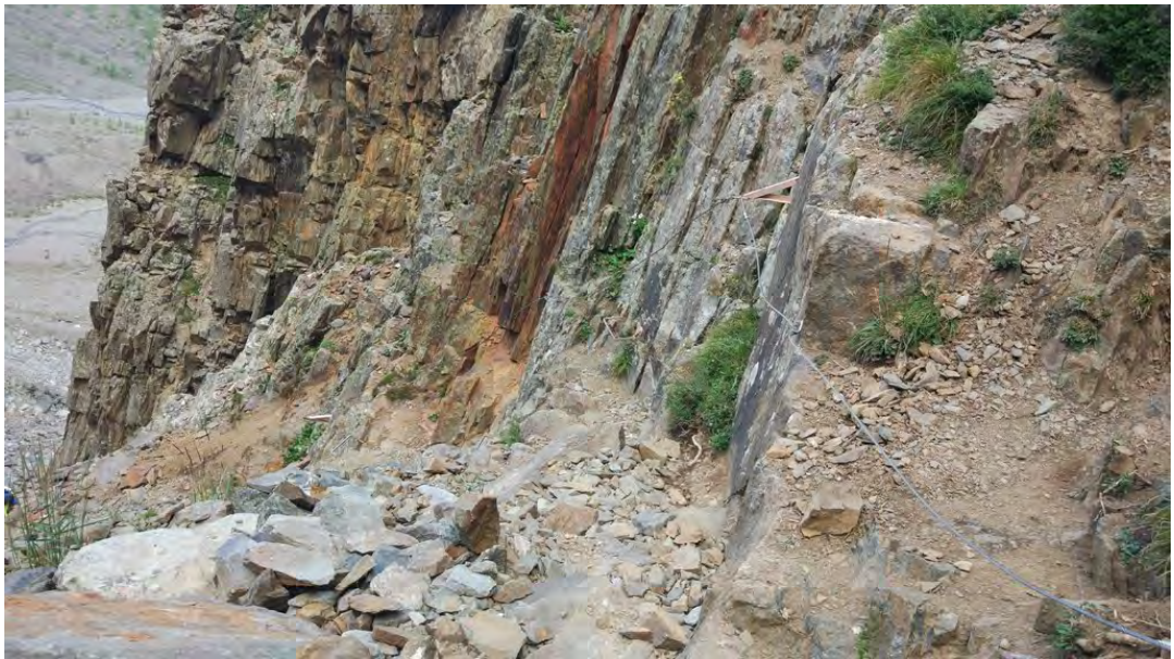
Фото 23. Провешенный тросом участок.
