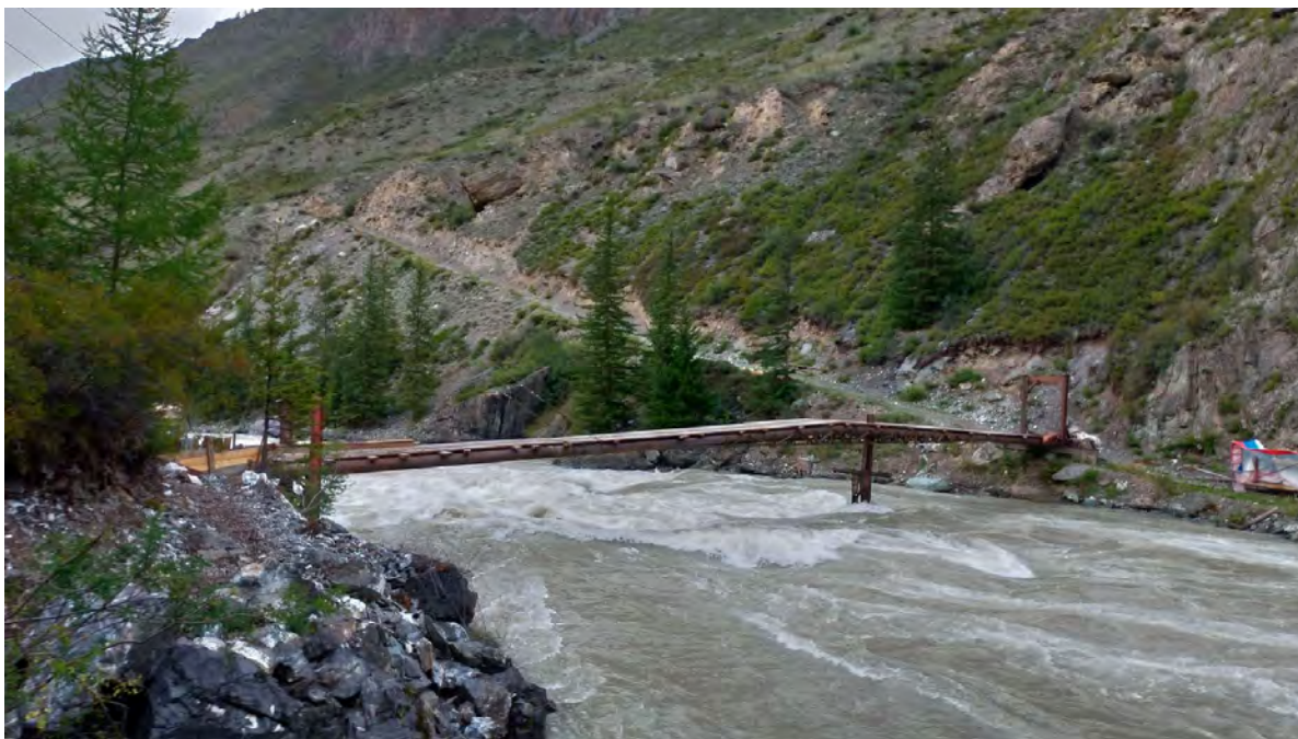
Фото 03, Мост через р. Чуя
