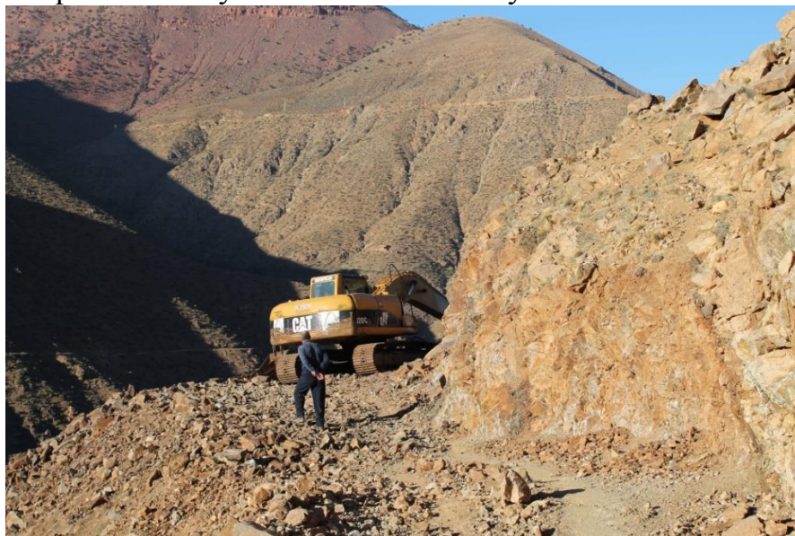
Фото 74. Строительство дороги в дер. Таматер
