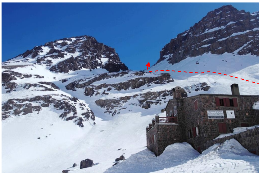
Фото 80. Приют Нельтнер, путь на Тубкаль
