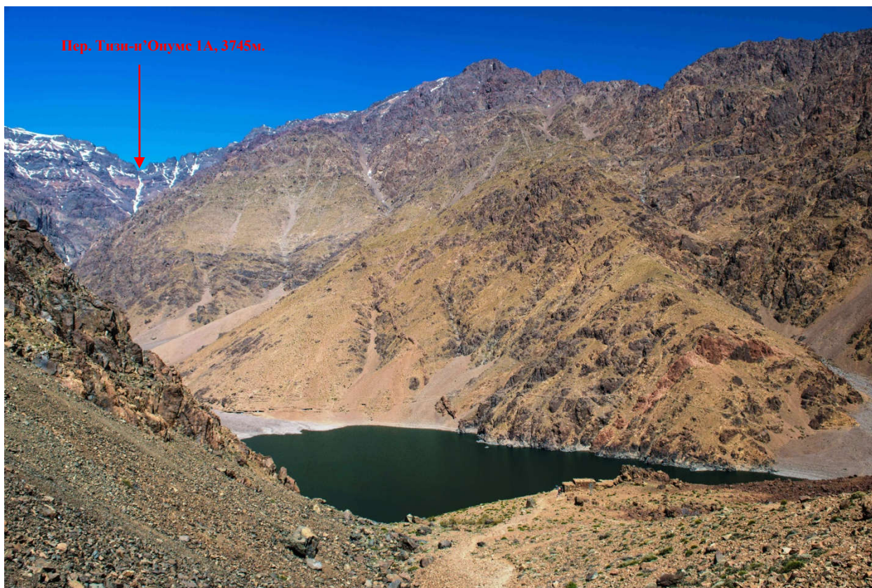
Фото 43. Вид с перемычки на озеро Ифни
