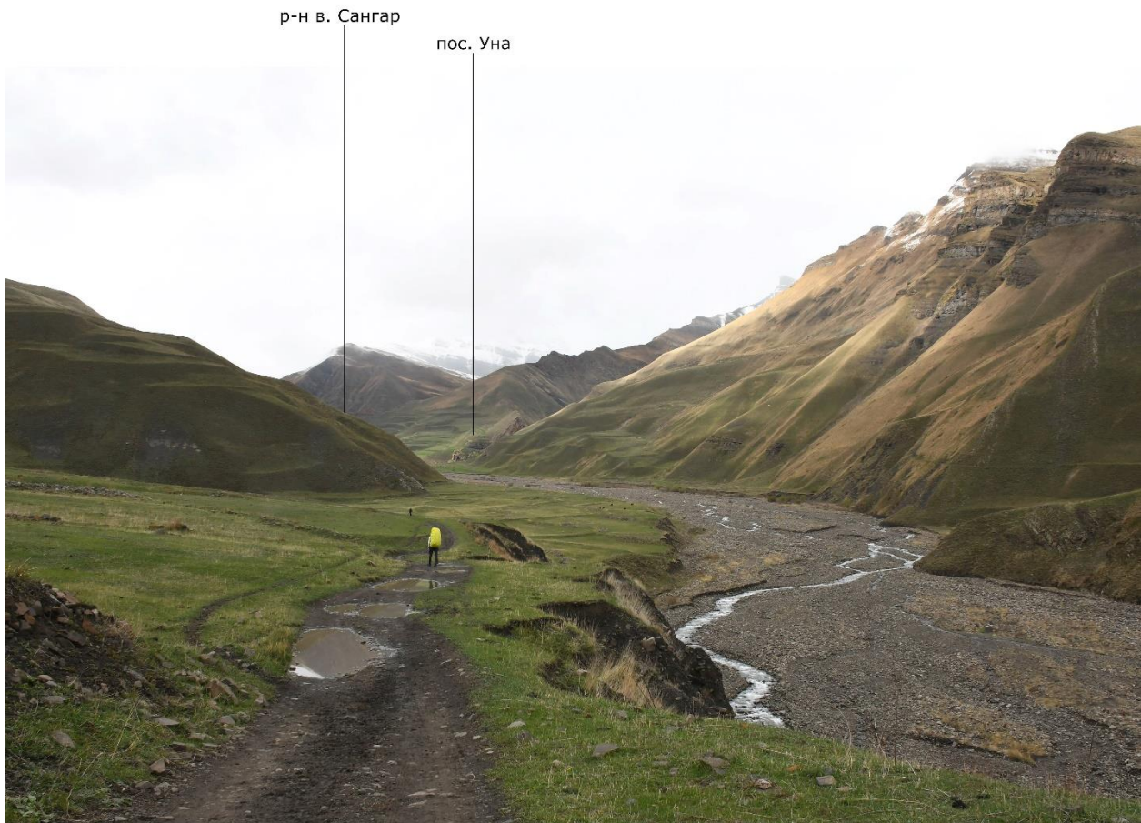
Фото 5.9 Автомобильная дорога правым берегом р. Шиназчай.
