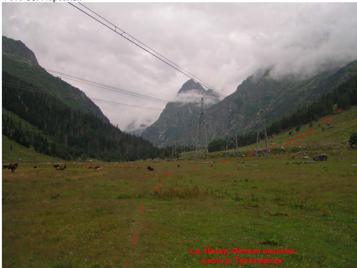
Фото 37. Начало подъема к р. Трехозерная
