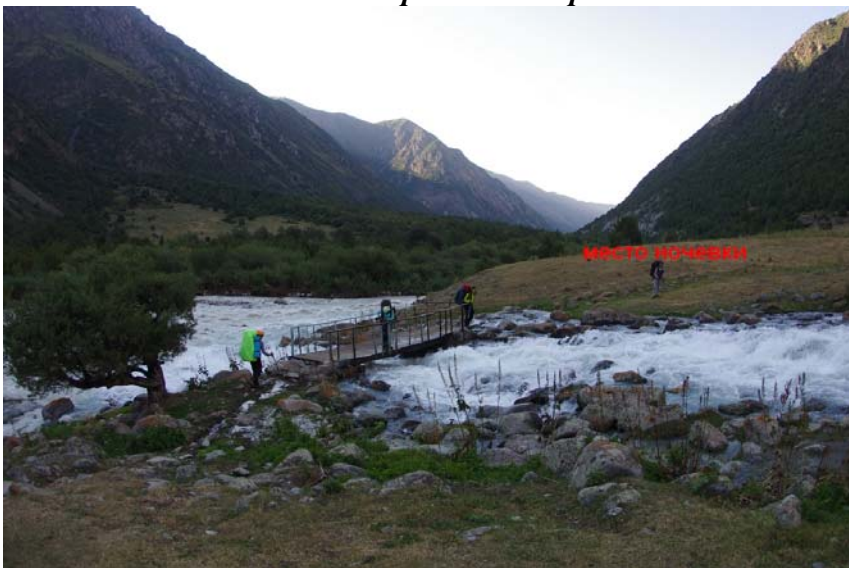
Фото 129. Мост через р. Салык (правый приток Аламедина).
