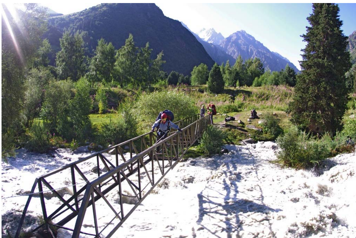
Фото 1. Гидромост через р.Ала-арча у тропы в д.р.Адыгене.
